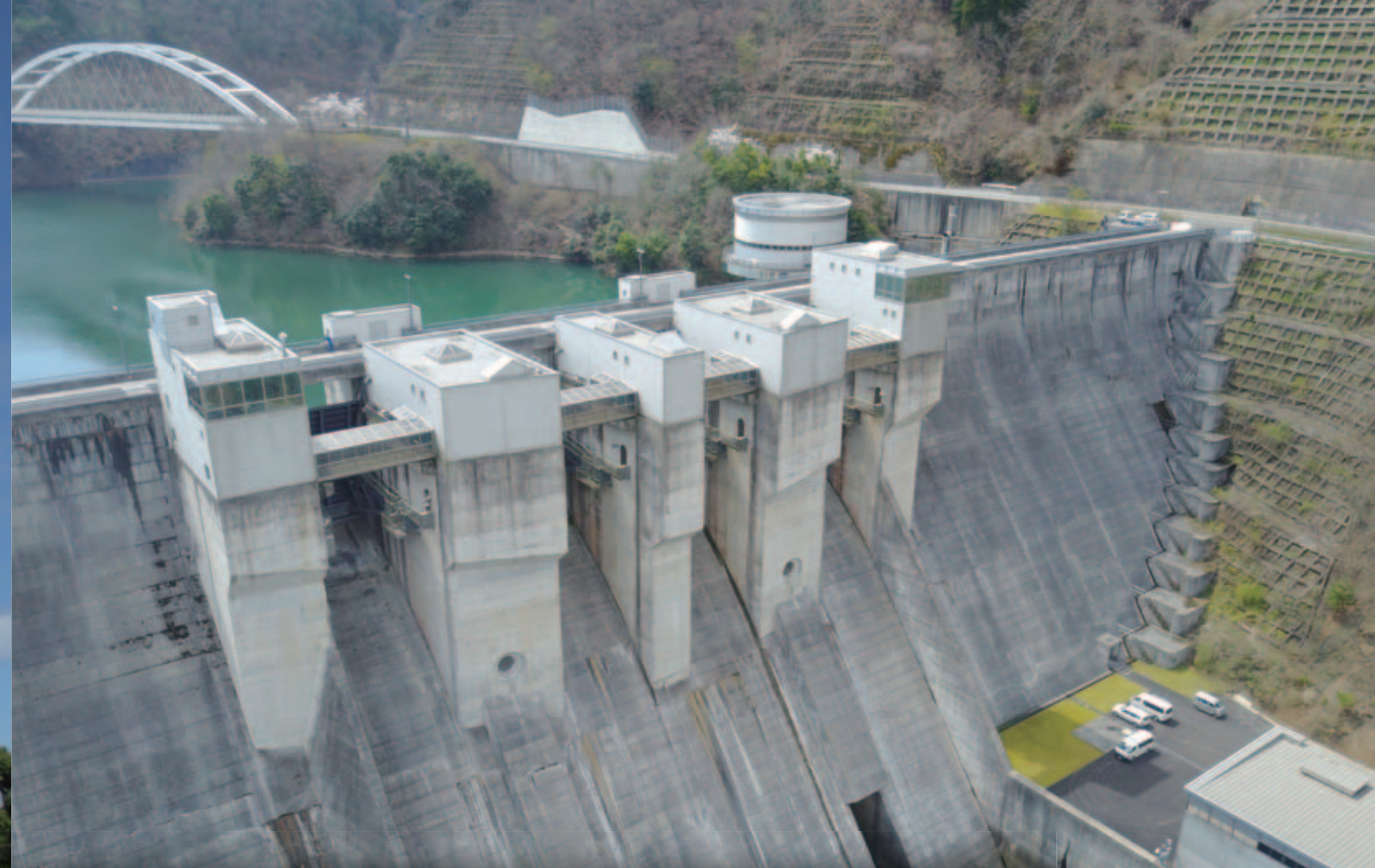
ダムからの放流を 制御する機械の上屋
