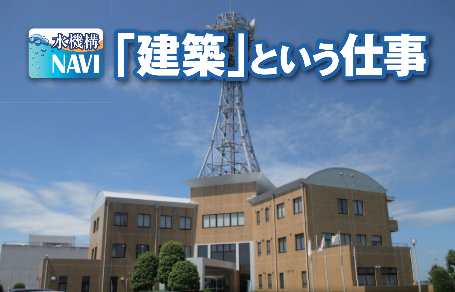
施設を維持管理する 管理所
