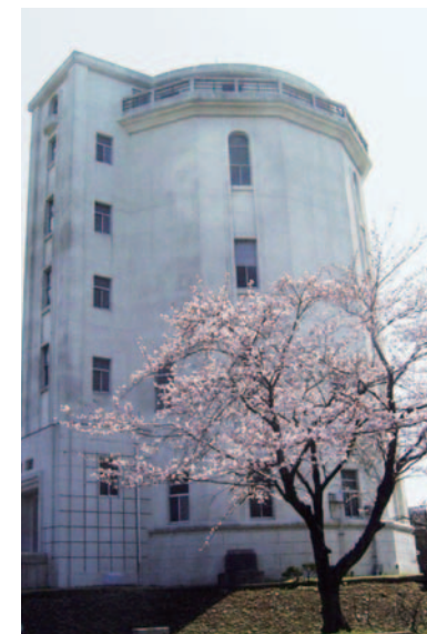
千葉高架水槽
