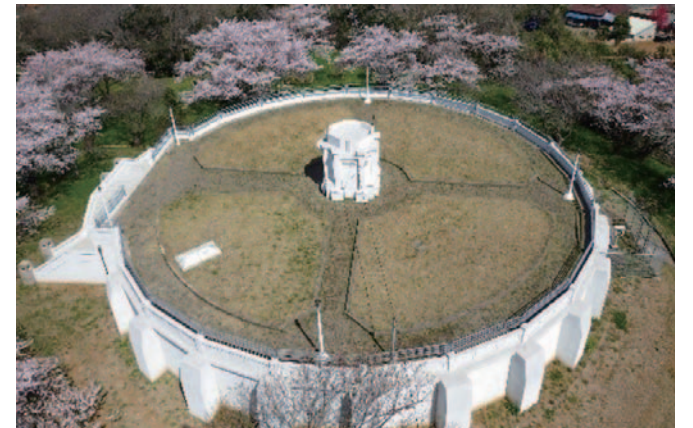
千葉分場1号配水池
