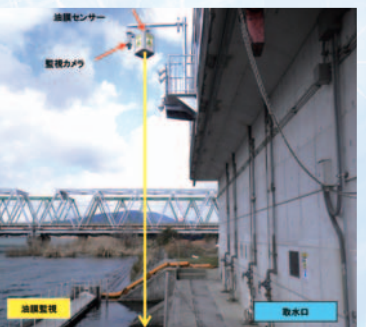
油膜センサー設置
