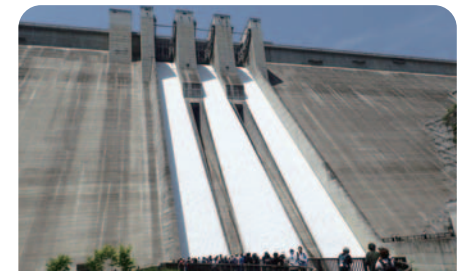
4年ぶり Crest 点検放流(平成30年5月)
