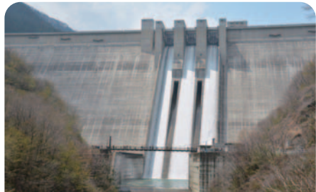
管理後初の Crest 点検放流(平成26年4月)
