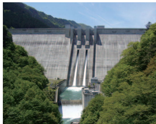
常用洪水吐きゲートからの放流
