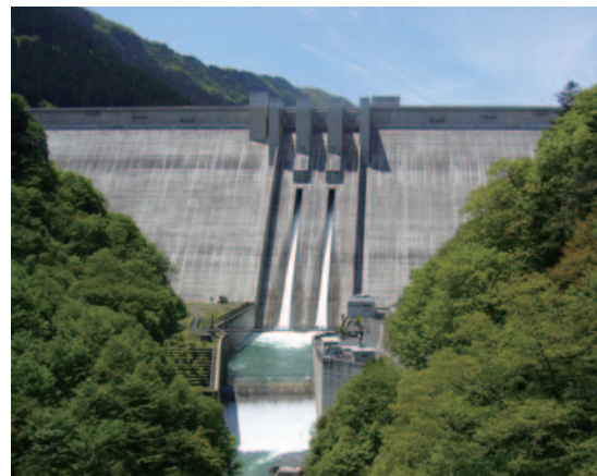
常用洪水吐きゲートからの放流
