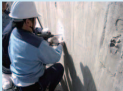
コンクリート健全度調査 (中性化深さ測定)
