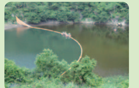
分画フェンスによる淡水赤潮対策 (青蓮寺ダム)
