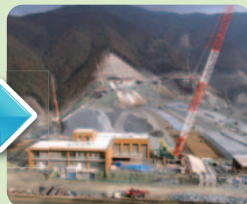
実際の施工状況
