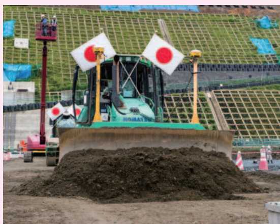
最後の敷均し
