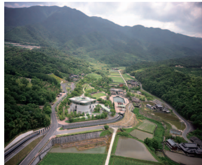
香川用水東西分水工(下流より)
