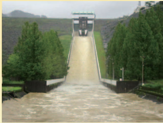
緊急放流中の寺内ダム
