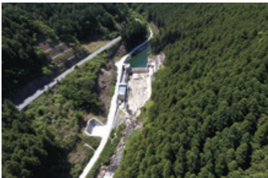
流入水バイパス設備
