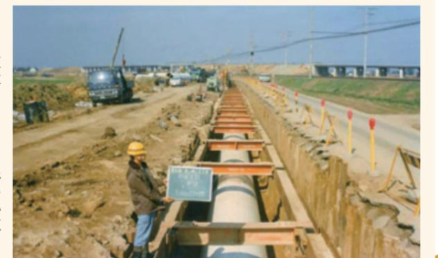
建設当時の鋼管布設の様子
