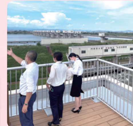
利根大堰の現地調査
