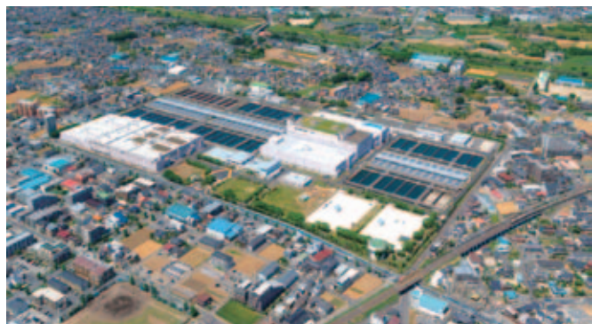
朝霞浄水場全景
