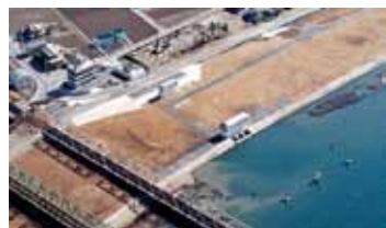
長良導水取水口（三重県桑名市）
