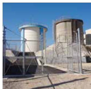
日間賀島配水池
