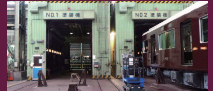
車体がすっぽり収まる巨大な塗装機
