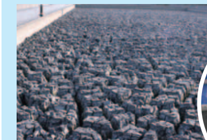
天日乾燥床（沈殿物を乾燥）
