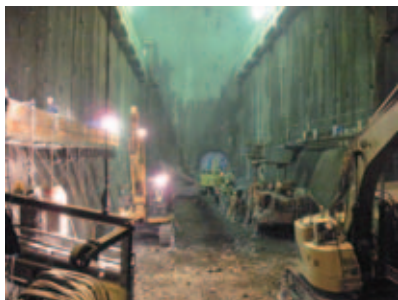
掘削中の1号主機室(地下空洞)
