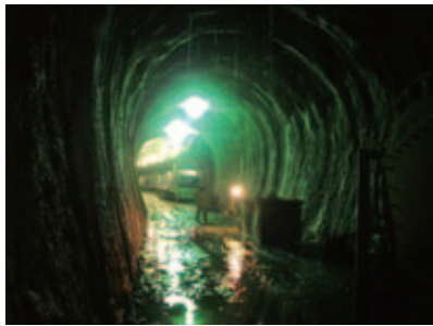
放水路トンネル掘削時
