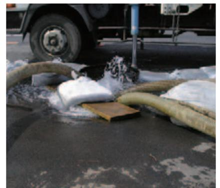
導水管空気弁破損による漏水状況
