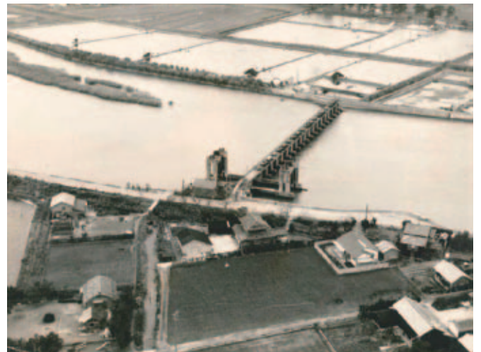
撤去される前の潮止樋門(旧吉野川)
