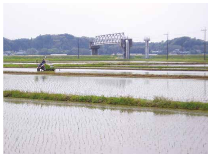
利根川沿岸を通過する水管橋
