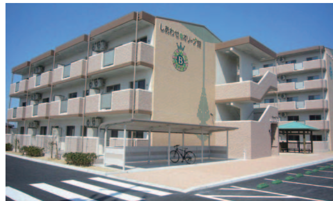
民間資金等活用事業(PFI)により整備した公営住宅
