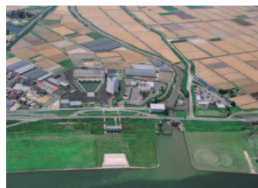
筑後川下流用水佐賀取水口・揚水機場
