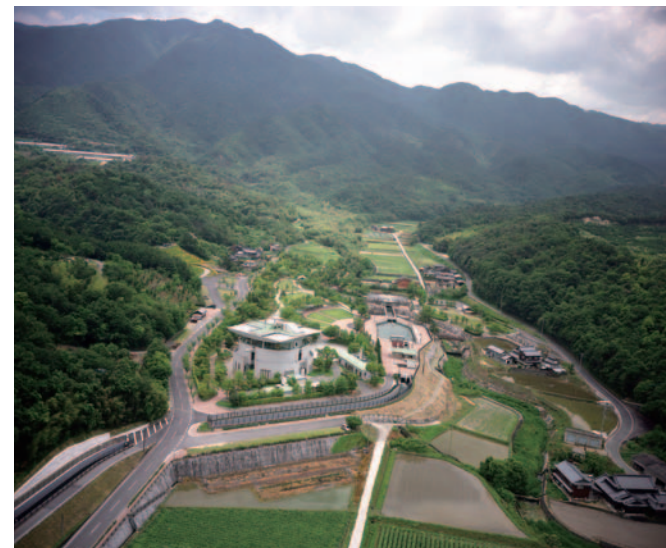
香川用水東西分水工(下流より)
