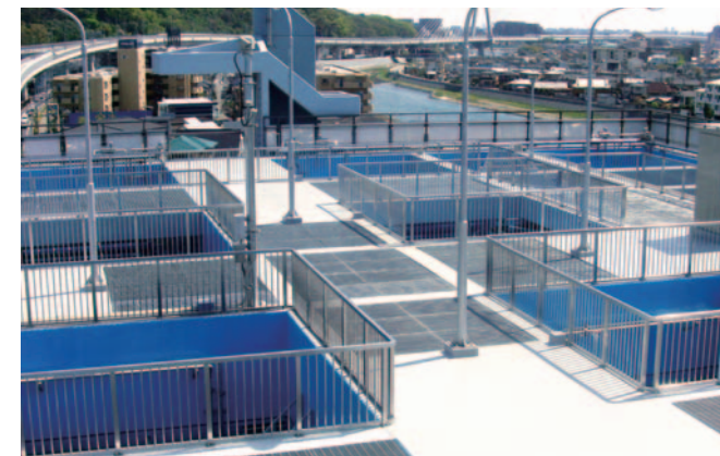
屋上の沈澱池
