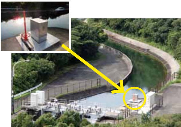
二川調節堰と発電機
