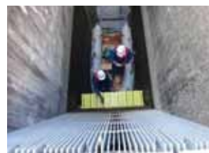
揚水機場の吸水槽スクリーンでの除去作業
