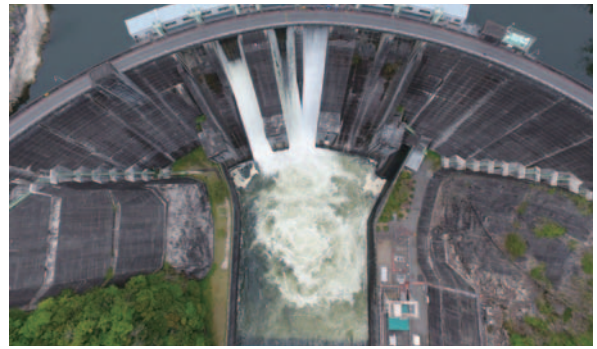
高山ダムのフラッシュ放流（クレストゲートからの放流）
