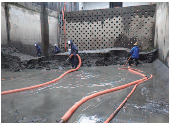
▲沈砂池の土砂撤去状況
