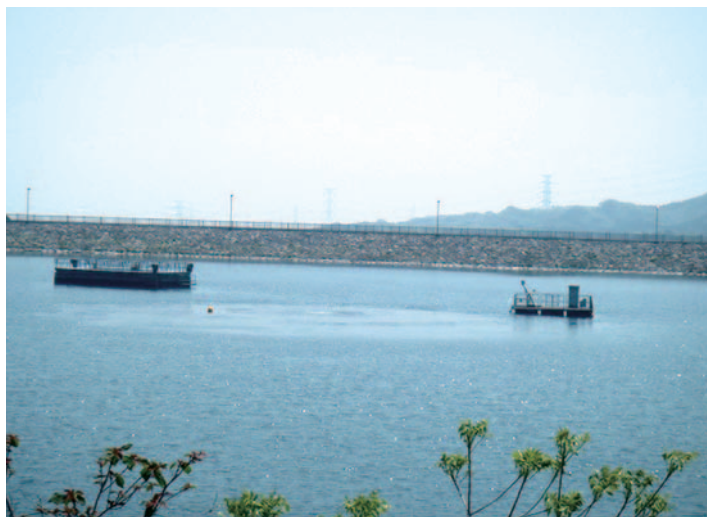
▲山口調整池曝気設備運転状況
