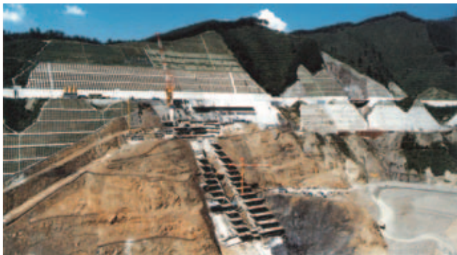
ダム堤体の基礎処理(ダム右岸)(S62年9月)
