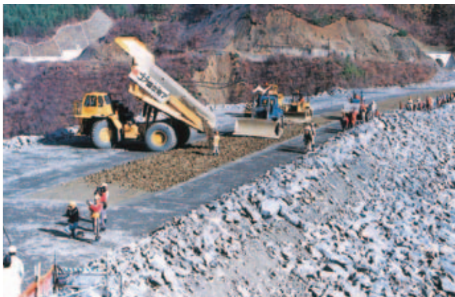
ダンプが最後のコア材を下ろす(H5年6月)
