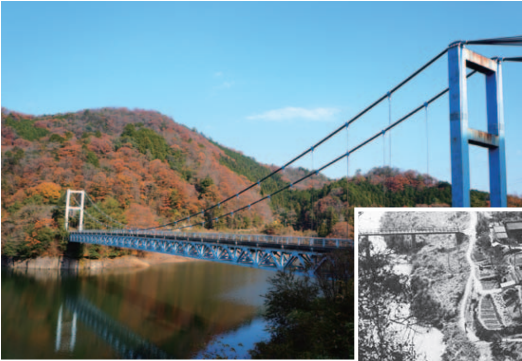
湖底に沈んだ川井の集落(写真下) 写真出典：『榛原町と室生ダム の建設』榛原町役場企画室発行
