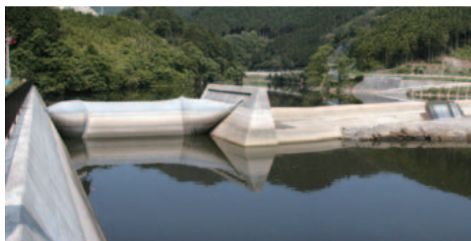
水質保全ダム。右岸(写真左手)にあるのがラバーゲート
