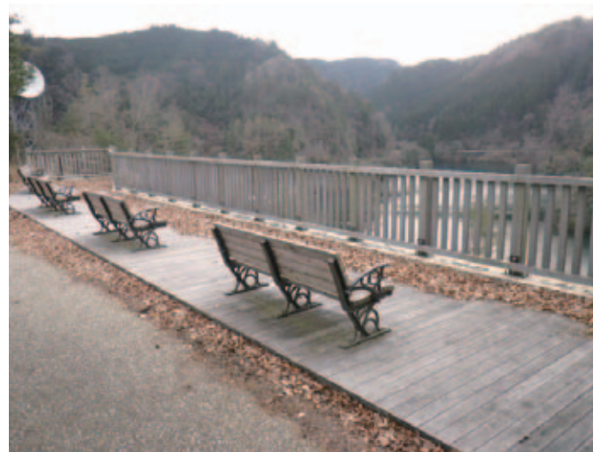
ダム湖活用環境整備事業で整備された室生ダム展望休憩所
