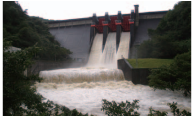
3門のクレストゲートから放流する室生ダム。平成21年10月8日の洪水操作時の状況
