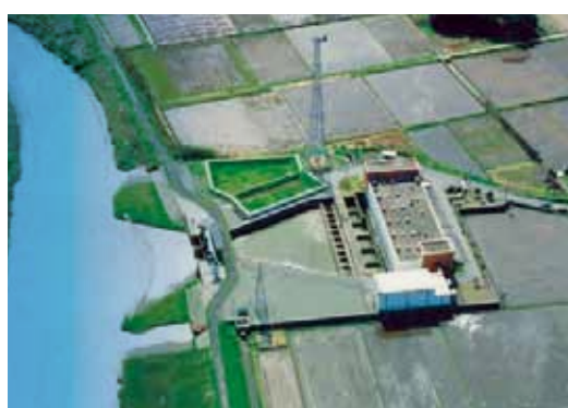
《横芝揚水機場》
