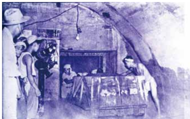
北部幹線用水路 20号トンネル（香取市伊地山地先）
