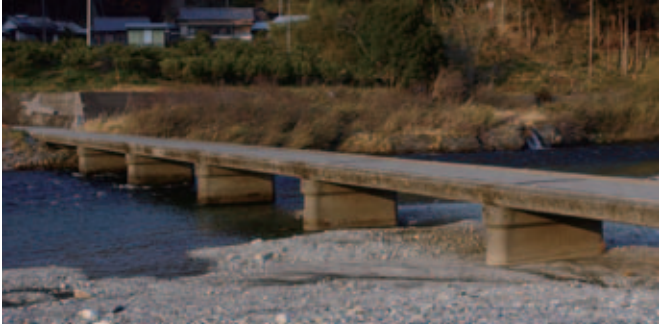
暴れ川をやり過す沈下橋。欄干がないのは洪水時に橋が水没しても流されないよう流水抵抗を減らすため。長岡郡本山町で
