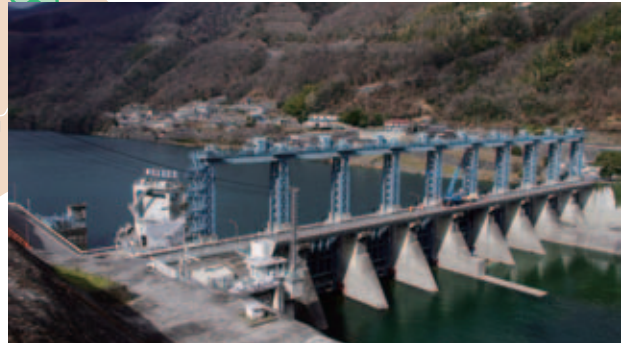
吉野川総合開発の一環として造られた多目的ダム・池田ダム。香川用水、吉野川北岸用水の取水口が設置されています。
