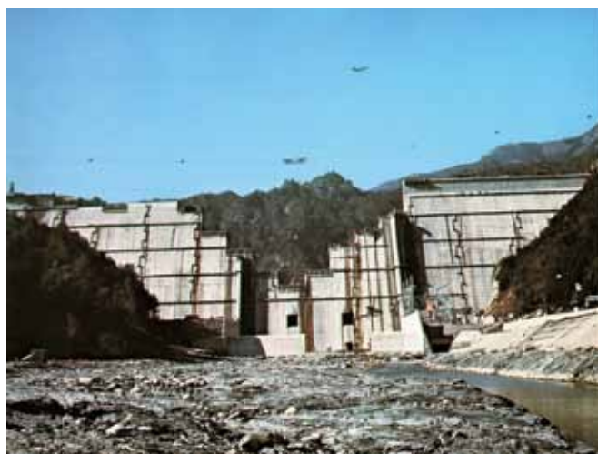
コンクリート打設中の堤体。ブロックに分けて施工しているため、ブロックの縦継ぎ目(手前側)に凹凸があること、型枠の高低差があることが分かります。
