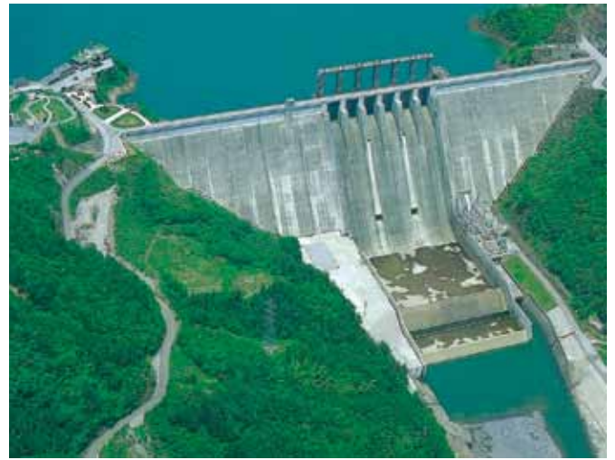
早明浦ダム堤体。堰堤の頂上部に洪水吐き用の6門のローラーゲート、最上部にはローラーゲートを巻き上げる昇降タワーが見えます。中間にある2つの孔は、利水用の放水口ですが、通常、堤体の向かって右下方に見える発電所を経由して放水されるので、ほとんど使われません。
