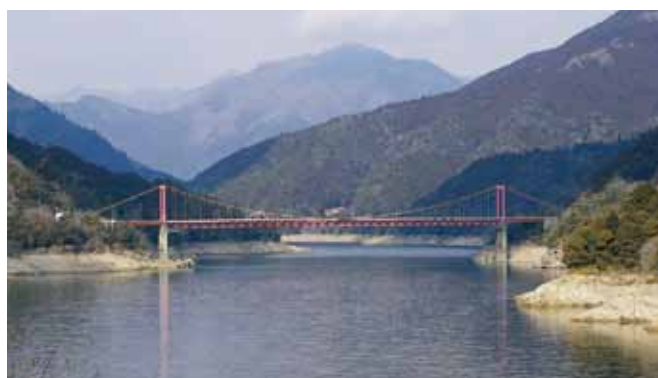
上吉野川橋。幅員6m、橋長321.36m
