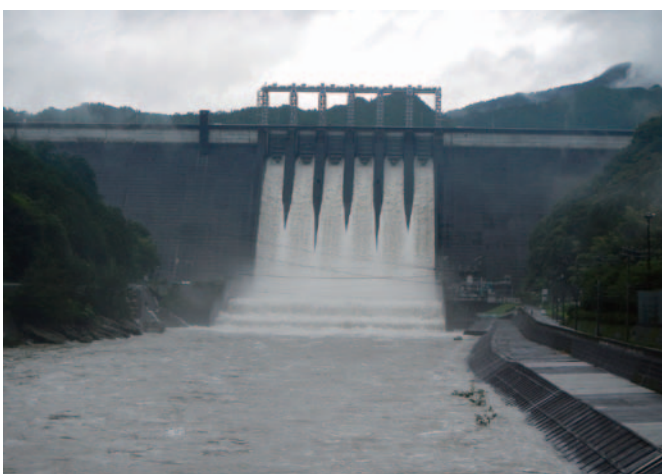
洪水調節中の早明浦ダム(平成26年台風12号)
