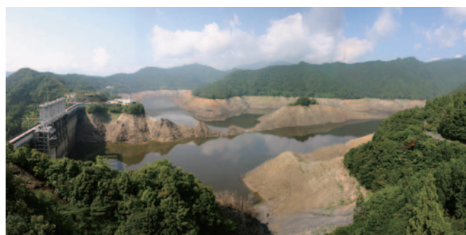
発電専用容量を除いた利水貯水率0% 平成17年9月1日8時
