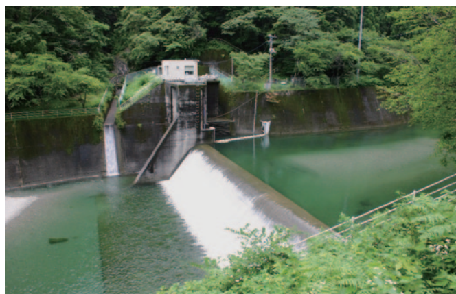
高知分水の瀬戸川取水堰
