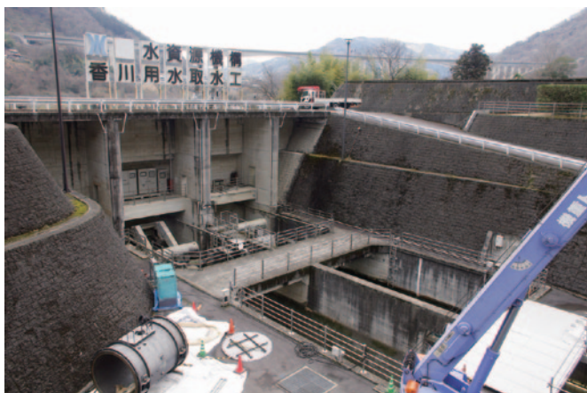
池田ダムの上流約1.8km地点にある香川用水取水工。ここから約8kmの導水トンネルで右上写真の東西分水工へ導水されます。
