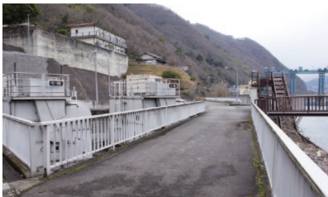
吉野川北岸用水取水工。右手奥に見えるのは池田ダムのローラーゲート。右手の流木がたまっているのは、ごみ除去のためのフローティングスクリーン
