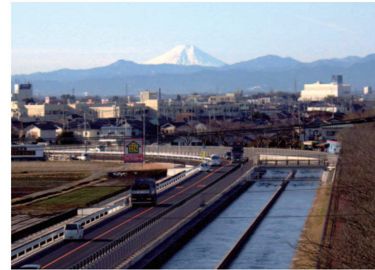
現在の武蔵水路(水資源機構資料より)
