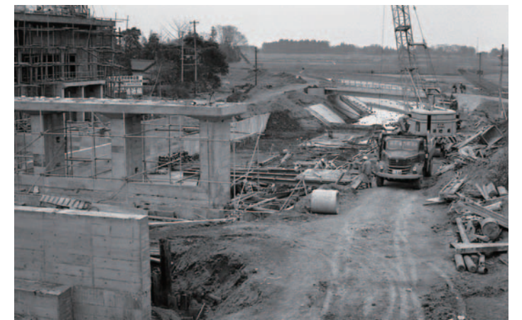
突貫工事の続く武蔵水路（水資源機構資料より）
