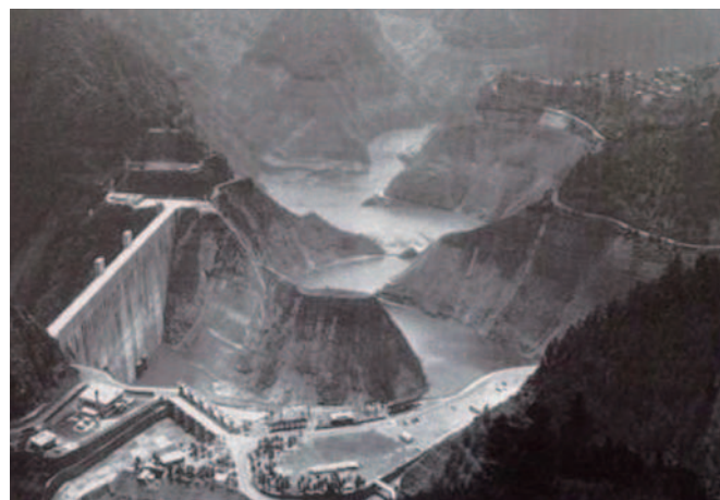
渇水時の小河内ダム (『東京近代水道の100年』(東京都水道局より))
