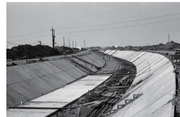
武蔵水路の工事風景(水資源機構資料より)
