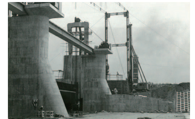
秋ヶ瀬取水堰の工事風景(水資源機構資料より)
