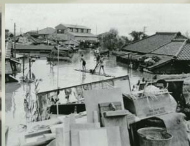
葛飾区 浸水状況
