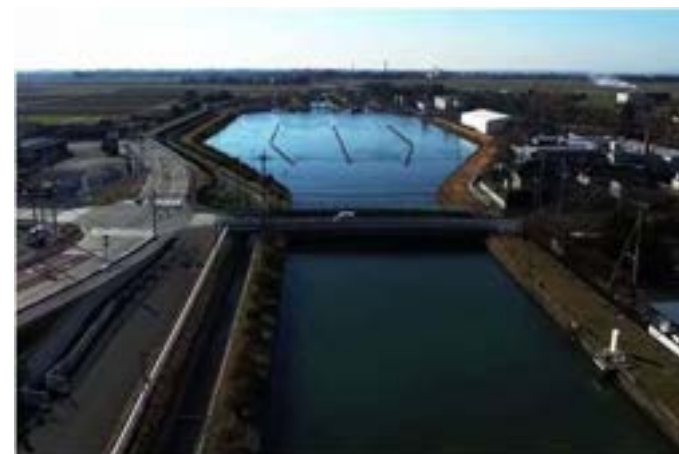
通常時の利根大堰大分水工
