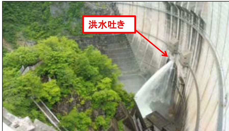
川治ダム コンジットゲートからの放流状況
