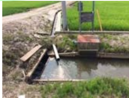
農水の反復利用釜場の設置
