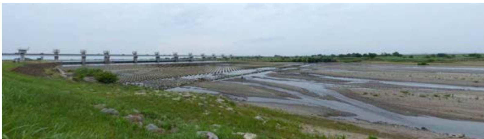
流量減少時の利根大堰下流状況
