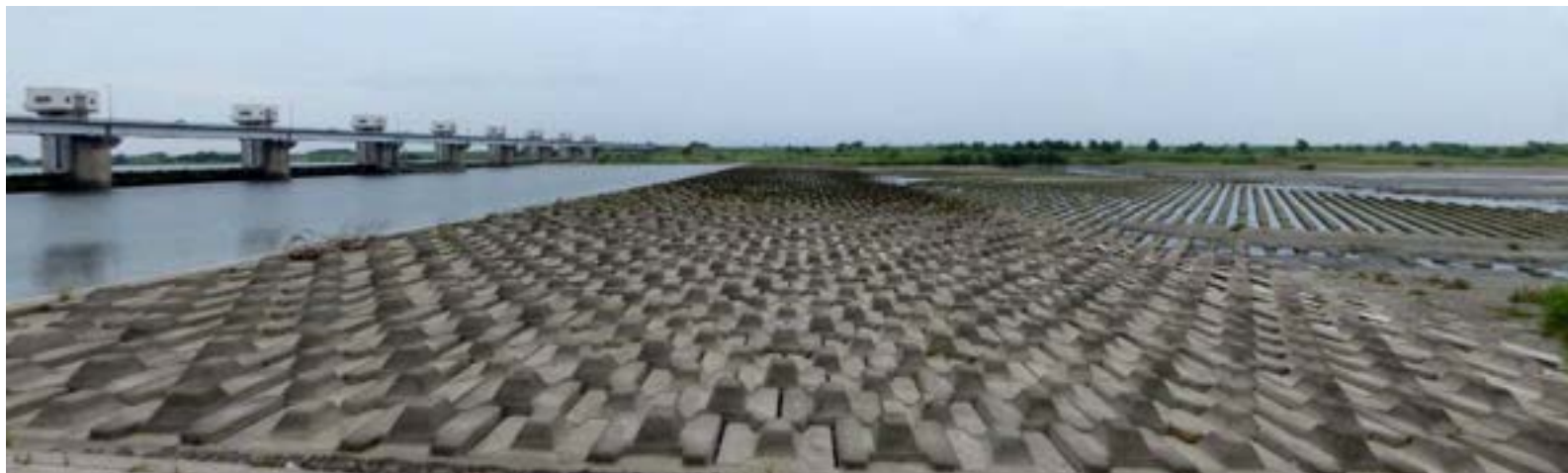
流量減少時の利根大堰下流状況
