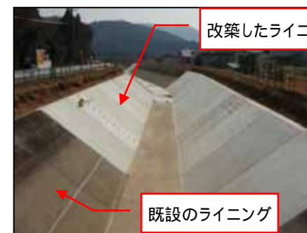
ライニングの状態に応じて部分的なライニングの改築や断面補修等で改築
