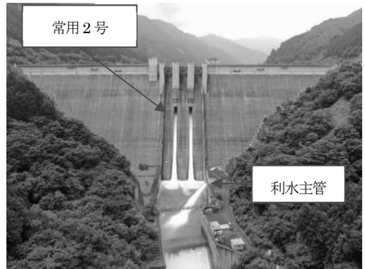
写真-5 遠隔操作試行状況 (11:16) 【常用2号開操作・利水主管閉操作】
