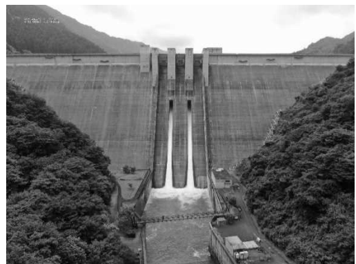
写真-6 遠隔操作試行状況 (11:21) 【利水主管全閉操作】
