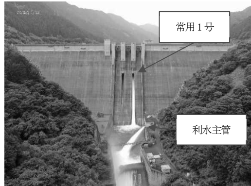
写真-4 遠隔操作試行状況 (11:06) 【常用1号開操作・利水主管閉操作(切替操作開始)】
