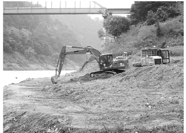
写真-3 高山ダム堆砂除去工事
