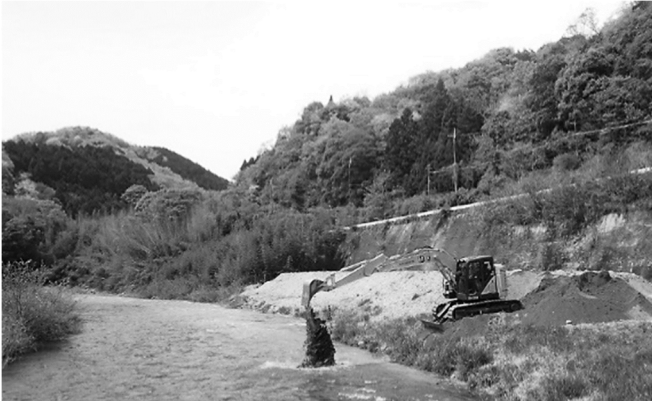
写真-2 木津川本川における土砂還元の実施状況
