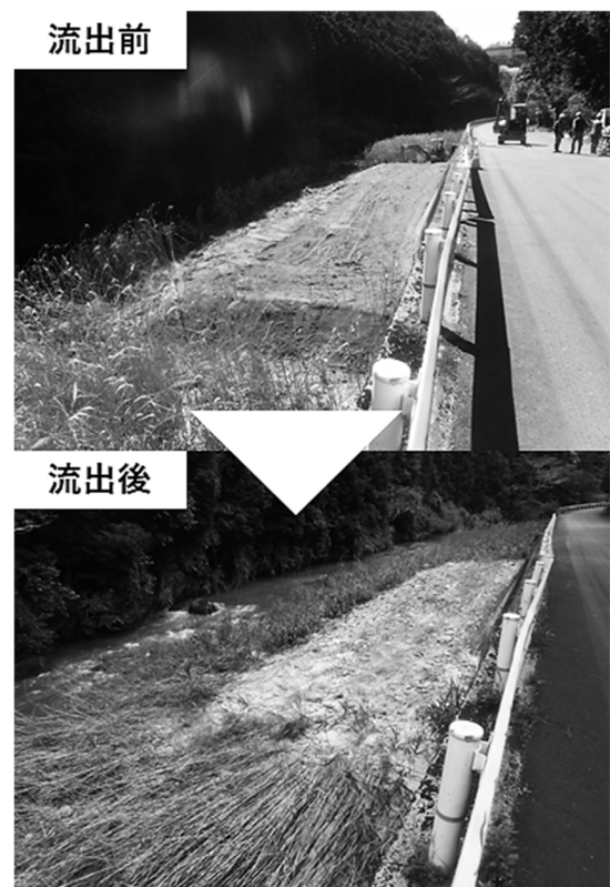
写真-1 布目ダム土砂還元の実施状況
