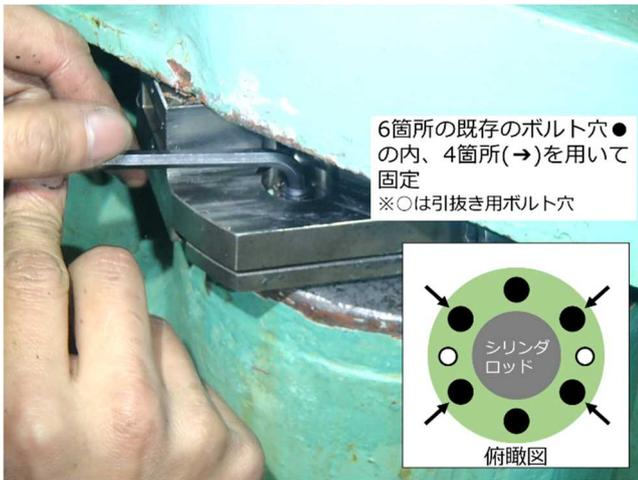
写真-7 固定に使用するボルト穴
