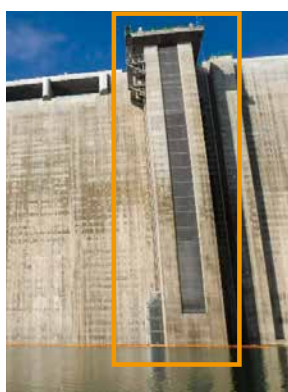
選択取水設備（川上ダム）
