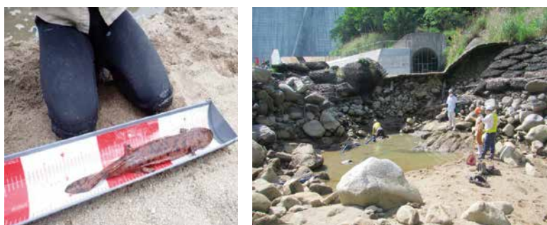
工事実施時のオオサンショウウオ保護（川上ダム）
