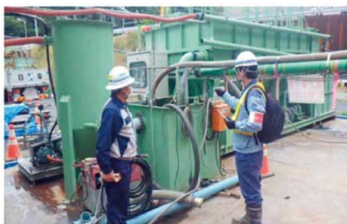
環境パトロール（濁水処理設備確認）の様子
