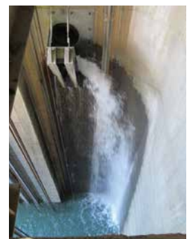
バイパス水路の吐出部
