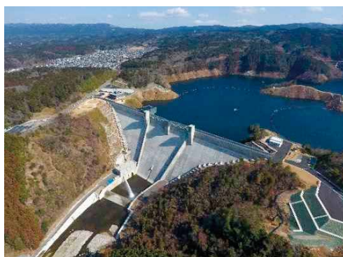
試験湛水中(令和5年3月) (川上ダム建設事業)
