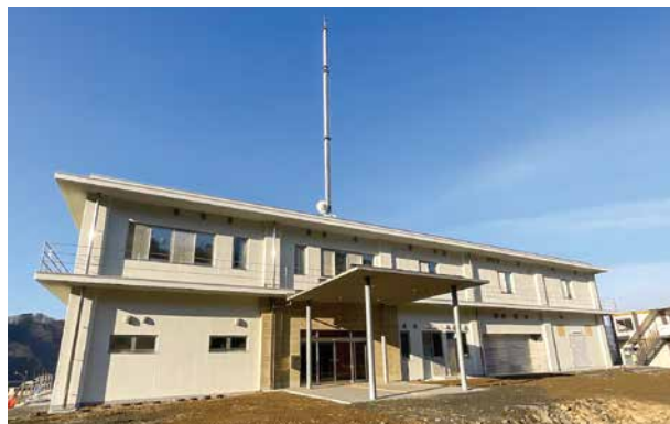
景観に配慮した管理棟（思川開発）
