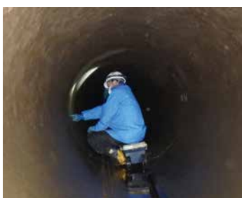
給水管内点検状況（千葉用水）
