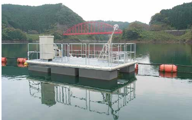
水質自動観測設備 (青蓮寺ダム)
