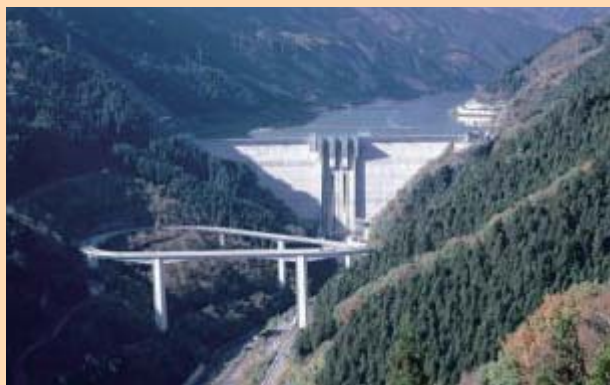
滝沢ダムと雷電廿六木橋
