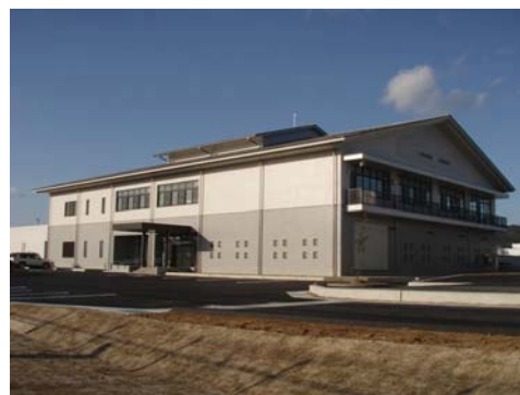
ゆめが丘浄水場管理棟
