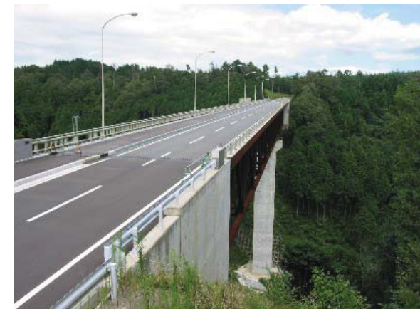
付替県道松阪青山線(要石大橋)
