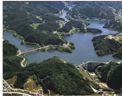
青蓮寺ダム S45完成 (F,N,A,W,P)
