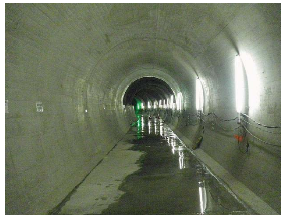
仮排水路トンネル(内部施工状況)
