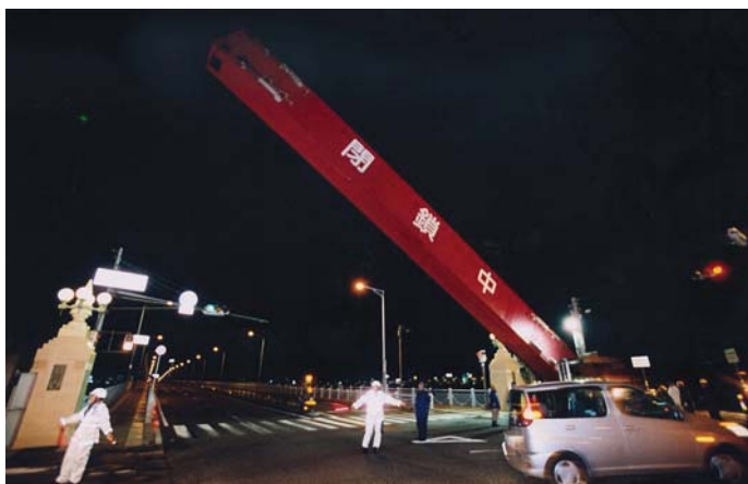
H16.8台風16号時の淀川陸閘閉鎖状況
