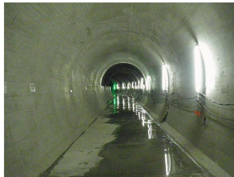
トンネル内全景
