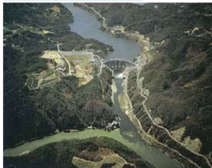
高山ダム S44完成 (F,N,W,P)
