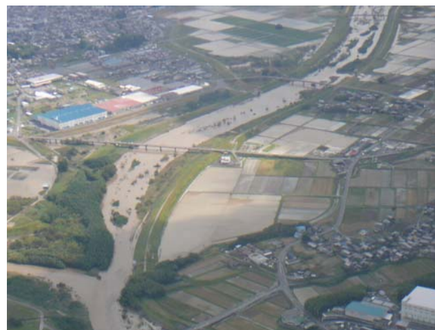
伊賀上野地区浸水状況
