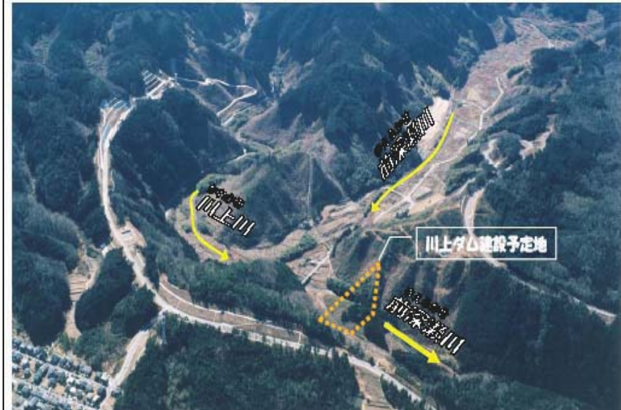
川上ダム建設予定地
