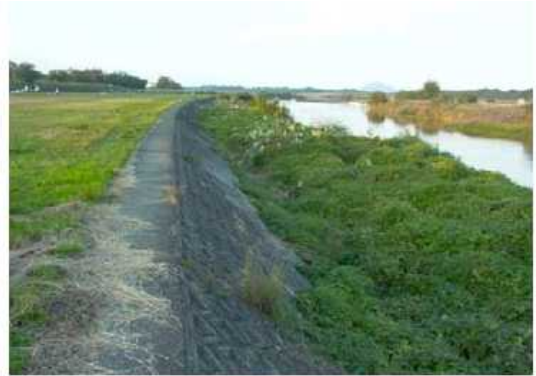
写真 2.3-5 コンクリート護岸
